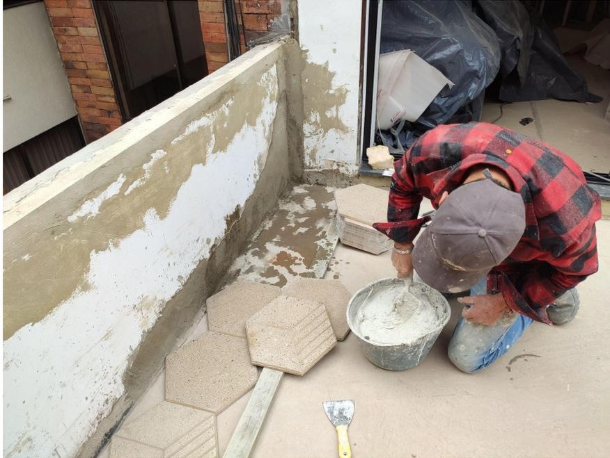
Imagen 2. Preparación del adhesivo y humedecimiento de la superficie y cara de la loseta.
