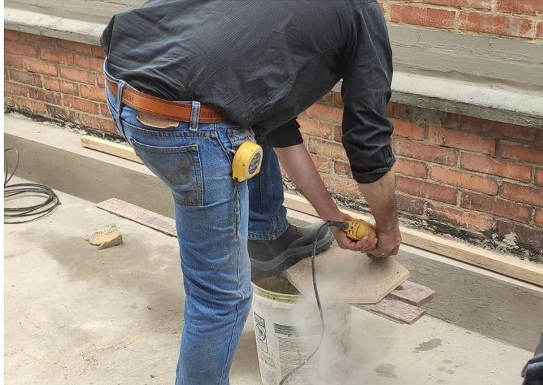
Imagen 6. Corte de piezas con pulidora de 4 1/2", 7" o 9", y disco de corte para concreto dependiendo del formato de la pieza.
