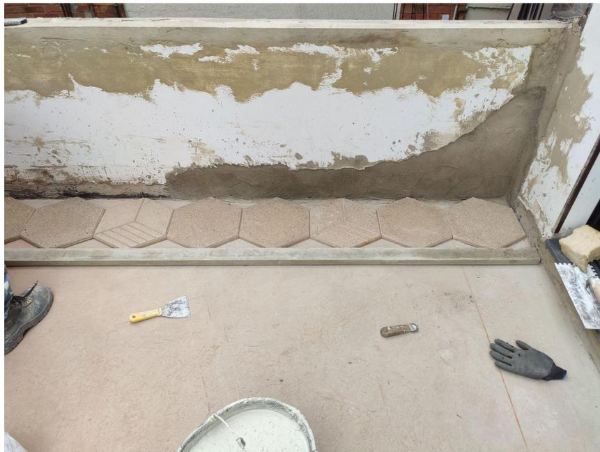
Imagen 3. Forme en seco para definir modulación, ejes y variación tonal.
